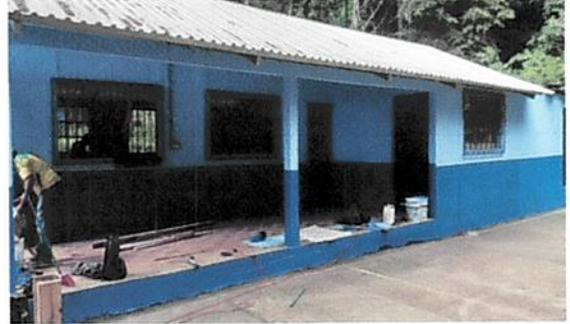
Foto 4: Sustitución de pintura, reparación de puertas y ventanas de la escuela, lámina de galera.
