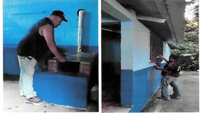
Foto 2: Sustitución de estufa y chimenea, pintura de cocina, instalación de Polletón, cambio de lámina y reparación de ventanas y puertas
