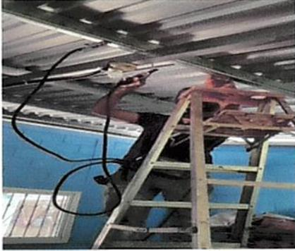
Foto1: Refuerzo de en estructura existente (Costaneras y tornillos)
